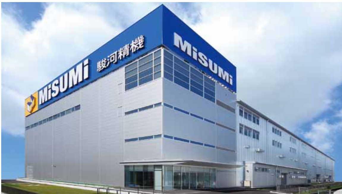
駿河生産プラットフォーム 清水工場
